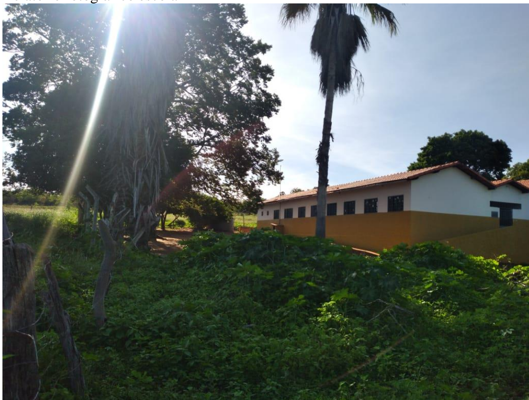
Local destinado para a construção da quadra. Ao lado do prédio da escola
